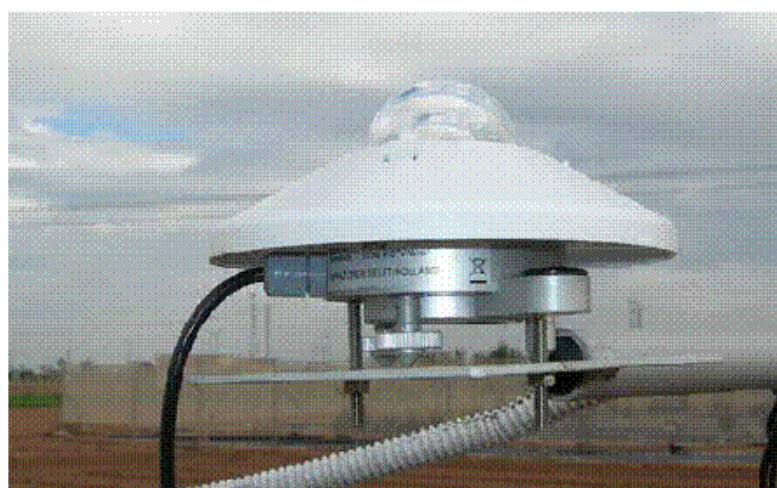
Figura I.4. Piranómetro modelo CMP3 de Kipp & Zonen instalado en la estación.
